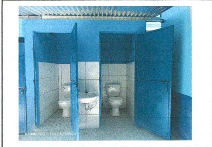
Foto 1: Mejoramiento e instalación de servicio sanitario para el nivel preprimario.
