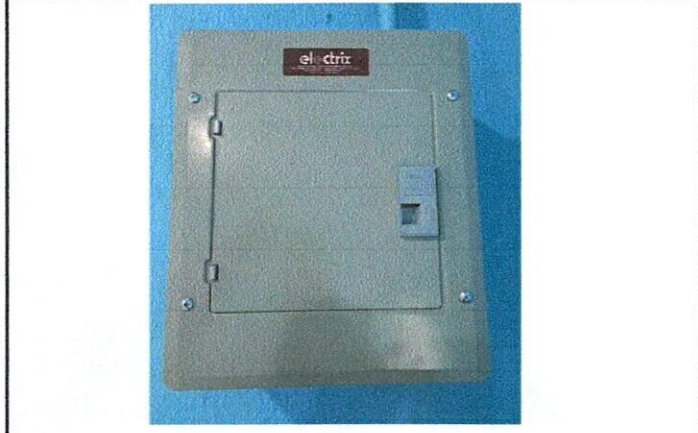
Foto 3: Mejoramiento y reparación de energía eléctrica del nivel preprimario.
